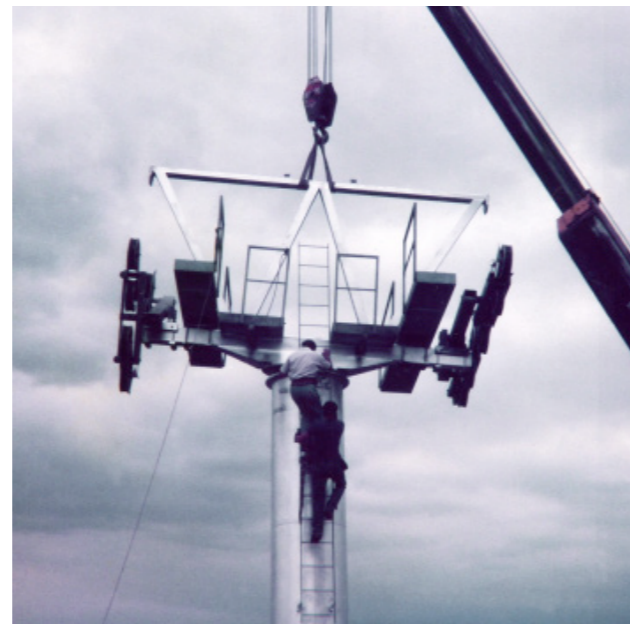
Instalación de la torre 8 Año 1988
