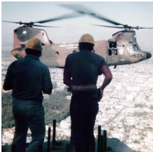
Construcción de la torres con ayuda de un helicóptero Año 1987
