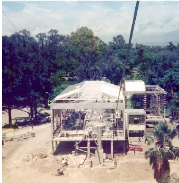
Construcción de la Estación Base Año 1987
